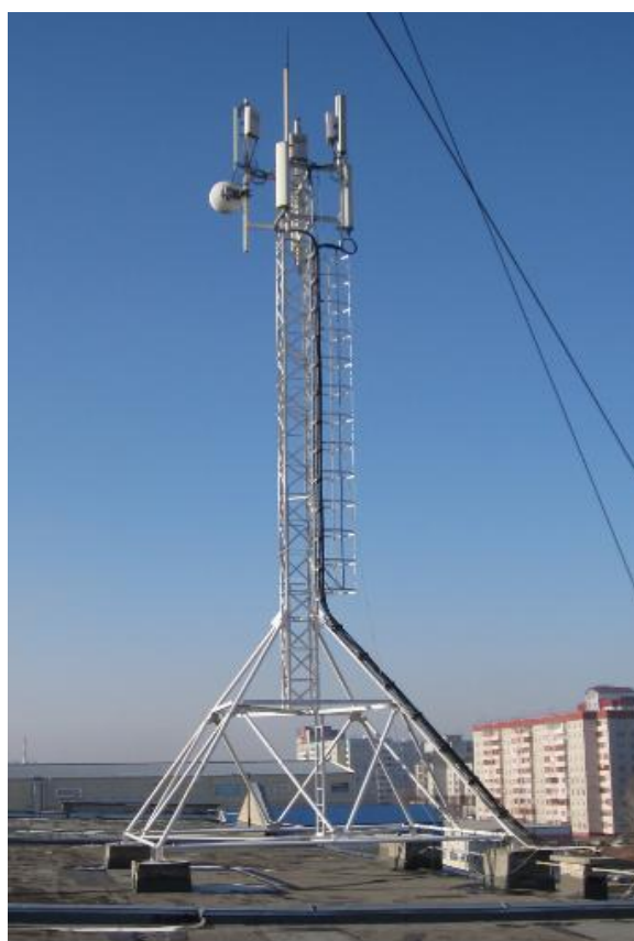
Рис. 7. Антенны, смонтированные на башне
