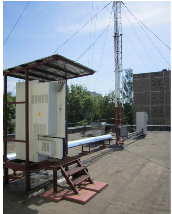
Рис. 3. Аппаратная, размещенная в телекоммуникационном шкафу
