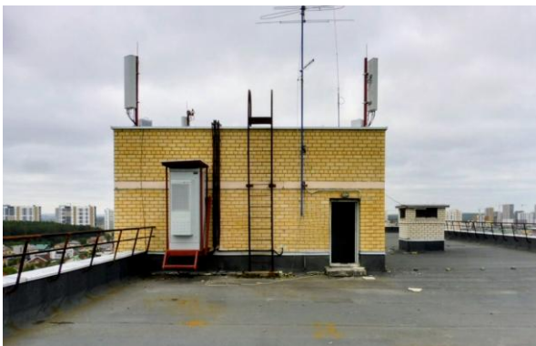
Рис. 41. Аппаратная, размещенная в телекоммуникационном шкафу
