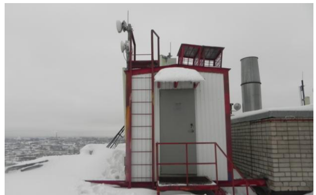
Рис. 52. Аппаратная, размещенная в отдельном контейнере
