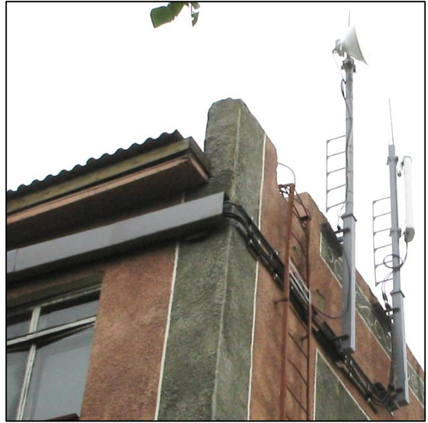
Рис. 120. Прокладка кабелей по фасаду
