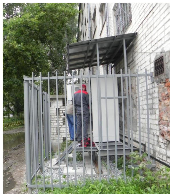
Рис. 118. Аппаратная, размещенная на земельном участке
